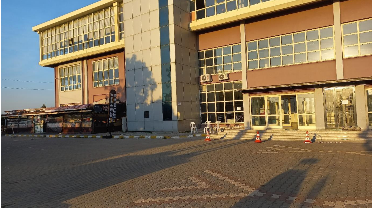
Görsel 9. ÖSEM binası ve yakın çevresi (8), 2024
